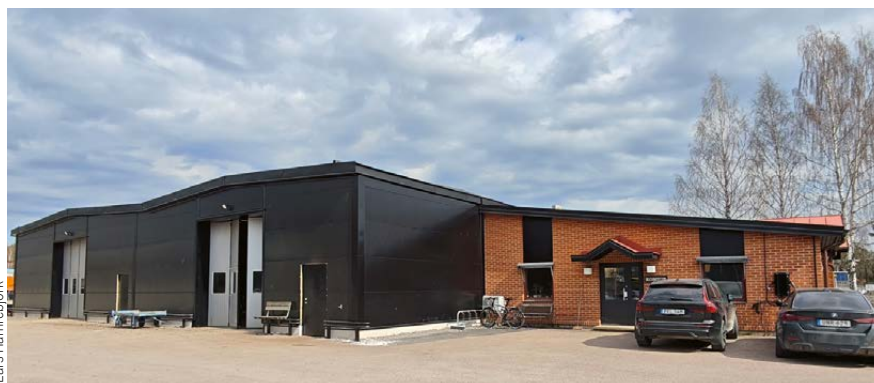
Kontoret och befintliga delen av verkstaden har fått en face lift med anledning av energieffektivitet och samma utseende som utbyggnaden, där en SWT-balk för montage av plattjärnen.
