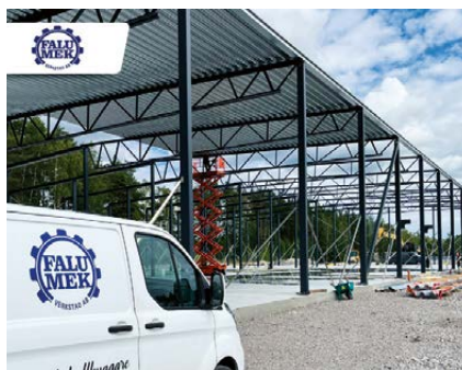
Ett aktuellt projekt är den nya Ahlsellbyggnaden i Falun. Falu Mekaniskas åtagande i detta projekt var större delen av överbyggnaden i form av egentillverkad stålstomme, montage av sandwichelement, bärplåt & entresolbjälklag etc
