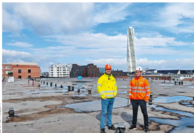
Den nya bostadsbebyggelsen på taket vilar på ett system av stålstolpar som överför lasterna till den befintliga fackverkskonstruktionen i Hall 259.
