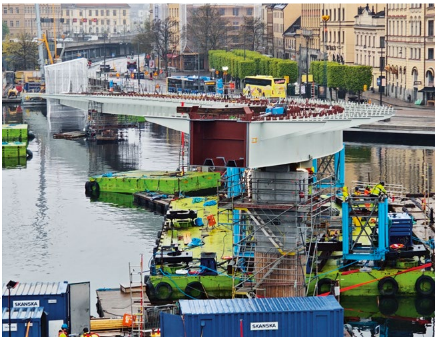
Sektion D på plats om monterad mot sektion C. Nu kan bronns slutliga utseende anas.
