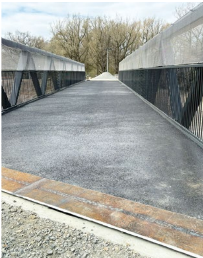
Nybyggnation av bro i Lund.
