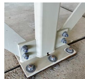
Skruvförband, fotplåt pelare-vindkruss.
