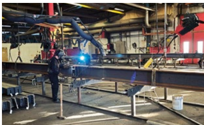
I den stora verkstaden sker här ihopsvetsning av kranbanebalkar till 24 meter.
