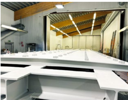
Nybyggnation av bro.
