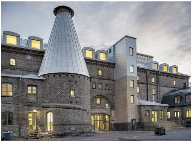
En historisk byggnad rustas för framtiden med hjälp av modern stålkonstruktion
