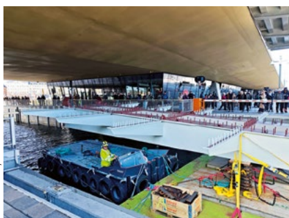
Brosektion A (28 meter lång och 57 ton) är på väg genom Victoriaslussen.
