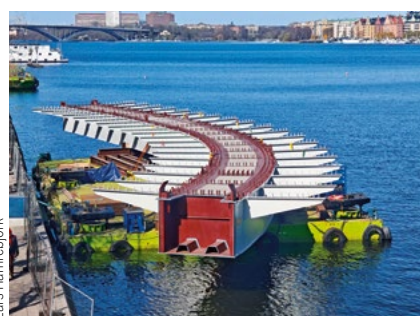
Brosektion D (57 meter lång och 157 ton) i väntan på att flyttas in på Slussenområdet.
