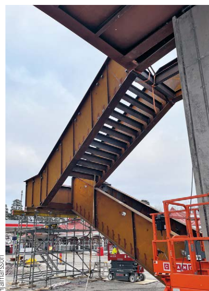
Montage av trapporna i väderbeständigt stål.
