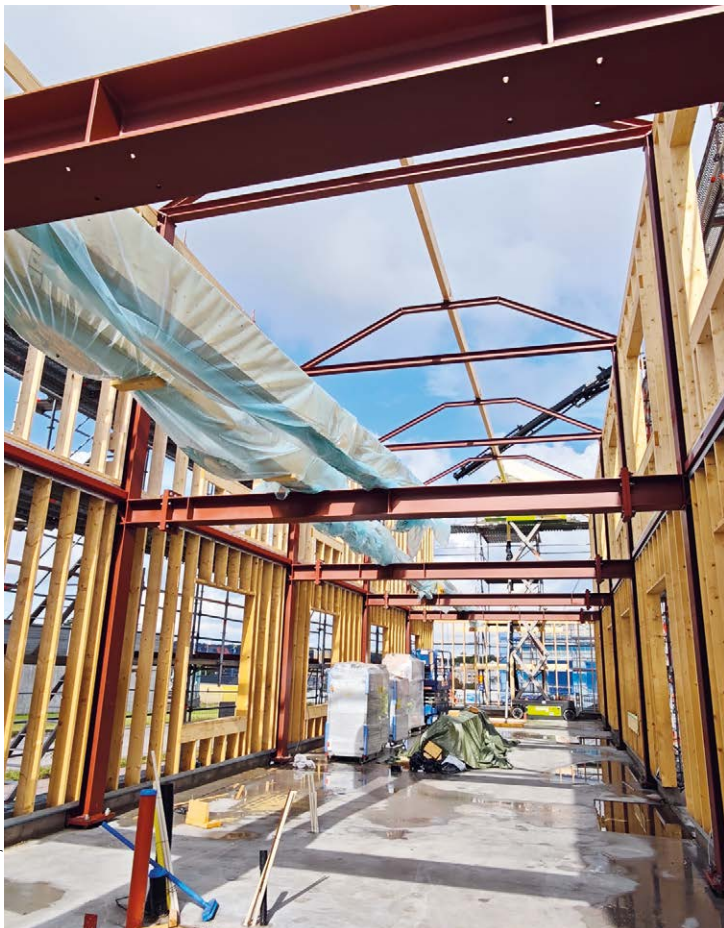
Återbrukad stålstomme där de gamla hålen får vara kvar i den nya stålstommen.
