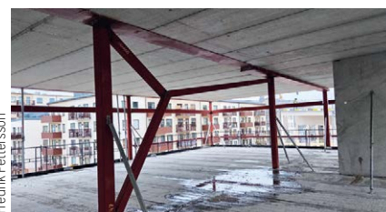
Knäckt vindstag för att skapa väggöppningar.
