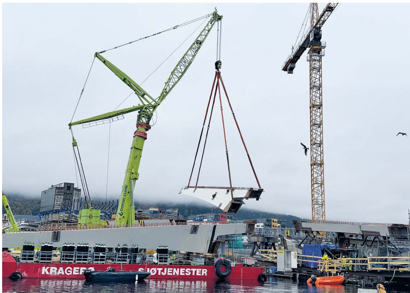
Montasje av stålelementer.
