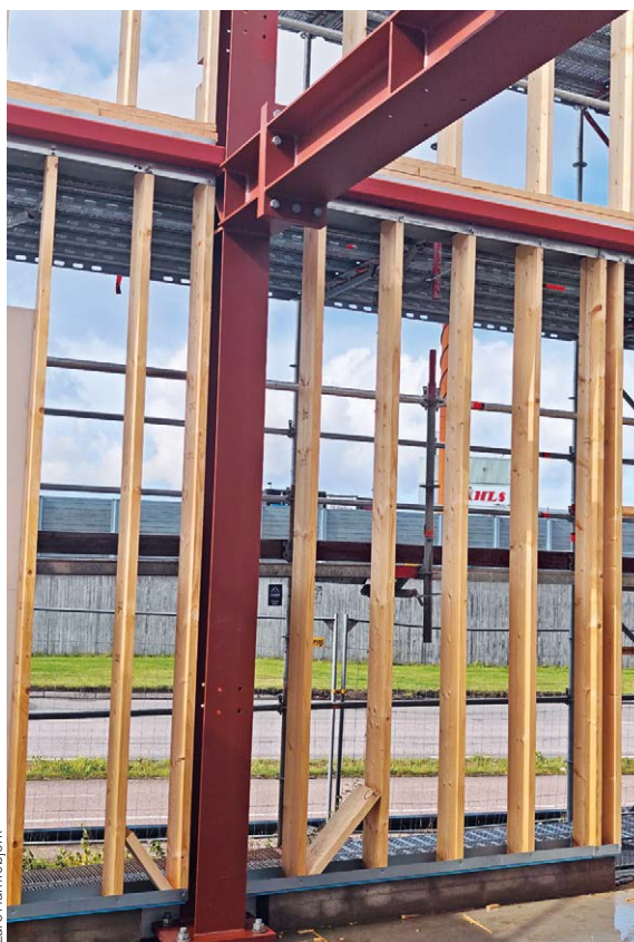
Återbrukad stålstomme där de gamla hålen får vara kvar i den nya stålstommen.
