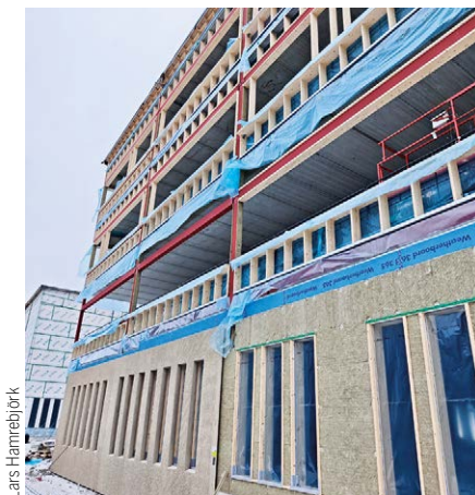
Stomme delvis inbyggd i utfackningsväggar.
