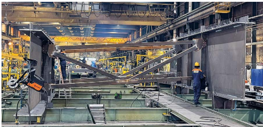
Stålproduksjon av Årbogbrua ved Nordec's fasiliteter.
