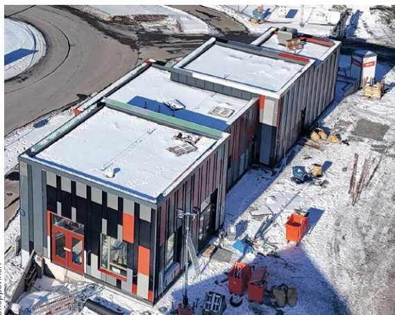
Cafébyggnaden med fasad av restplåtar i stål.
