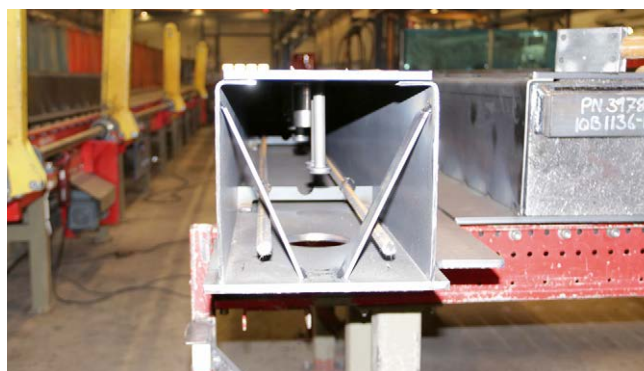
IQB balk i väntan på svets och ytterligare utvändiga detaljer och gjutning.
