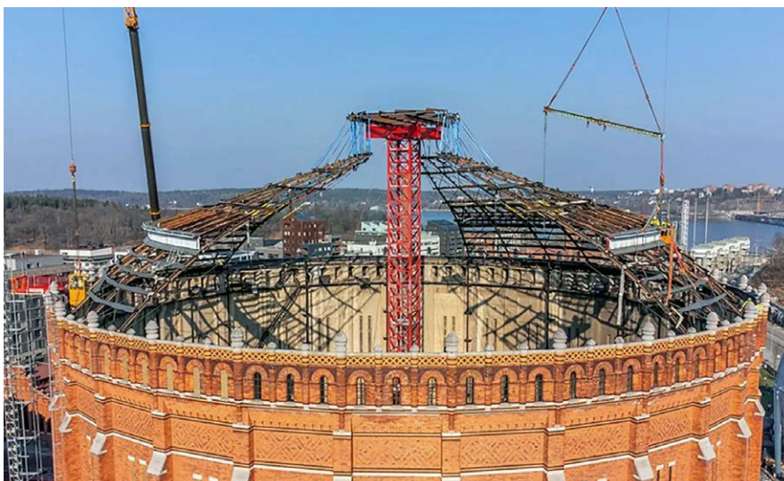
Rivning av taket på Gasklocka 2 under mars 2022.
