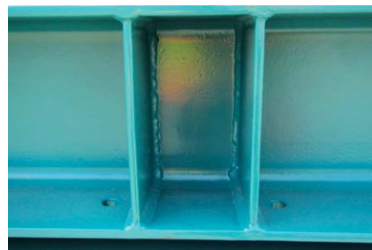
Förstärkning- och förstyrningsplåtar begränsar ofta återkomsten vid ytbehandling.
