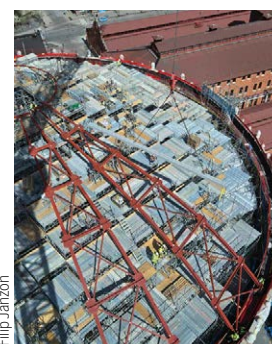
Två av 32 stycken "tårtbitar" av takkonstruktionen har monterats.
