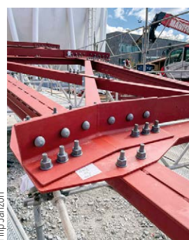
Speciella skruvar (TC-bolts) som "ska se ut som" nitar.
