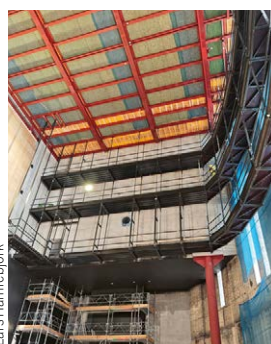
Teknikbryggor ovanför scenen på stora stålpelare.
