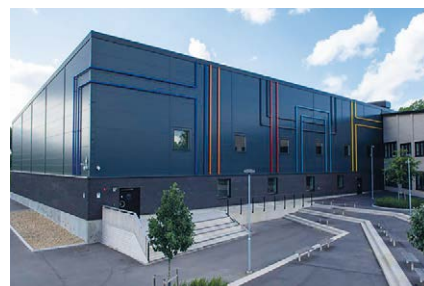
Bild 2. Horisontellt monterade paneler direkt mot fasadpelarna.
