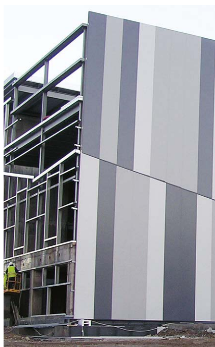
Bild 1. Vertikalt monterade paneler på sekundärstomme.
