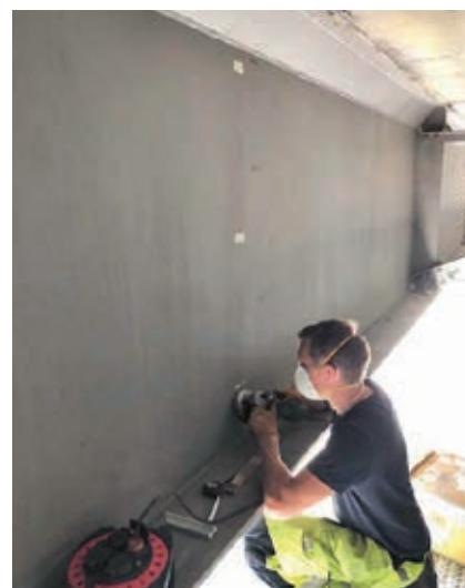
Figur 6. Instrumentering av bruva for lastforsøk,
