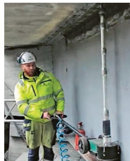
Figur 7. Installasjon av en coiled pinne.
