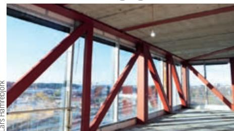
Fackverken i den utkragande delen på våning 10 var en av utmaningarna som krävde en väl genomtänkt monteringsplan för att kunna monteras säkert och effektivt.
