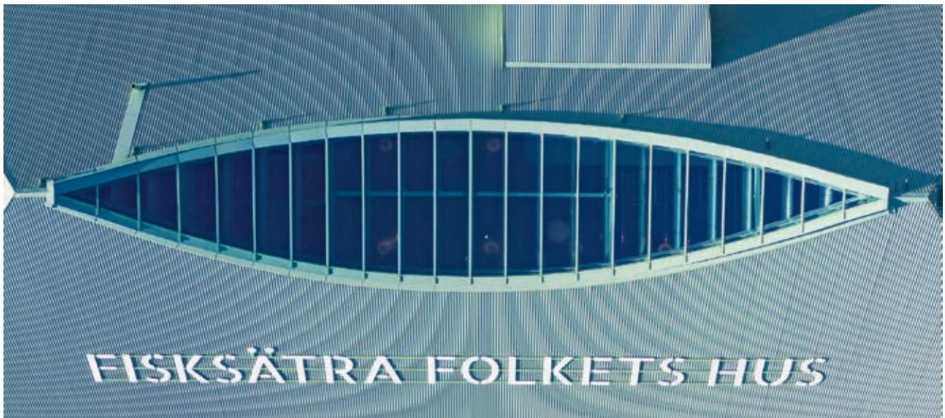
*Det ovala glastaket ställde stora krav på designen av båda stålkonstruktion och de sinuskorrugerade plåtarna.*
